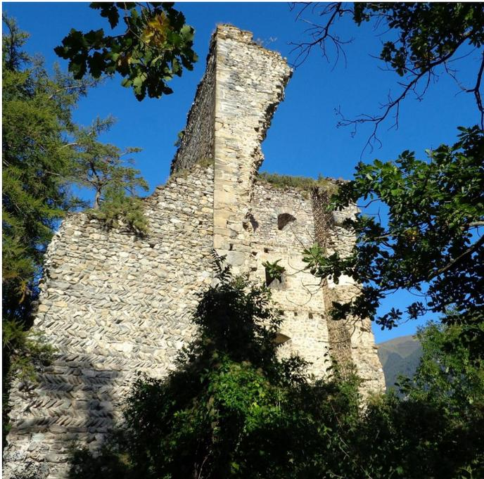
Alt Süns ist der erste Sitz der Freiherren von Vaz im Domleschg von 1216. An der 1451 durch Ausbruch der Fundamente einer Turmhälfte zum Einsturz gebracht Anlage hat sich eine Vielzahl originaler Baudetails erhalten. Ein steinernes Lesebuch für Fortgeschrittene in BurgenkundeÅ
